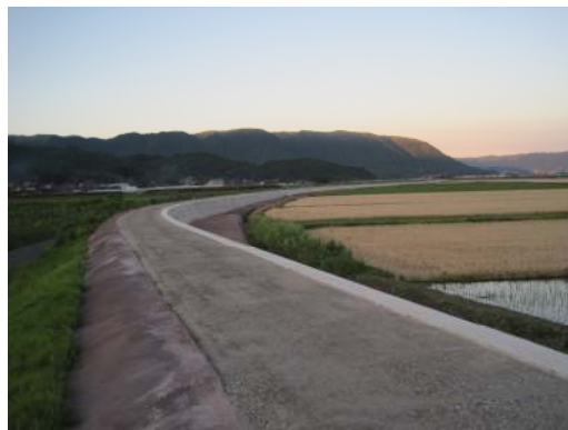
小倉遊水地(普段は水田)を囲む堤防 2015.6.6撮影
