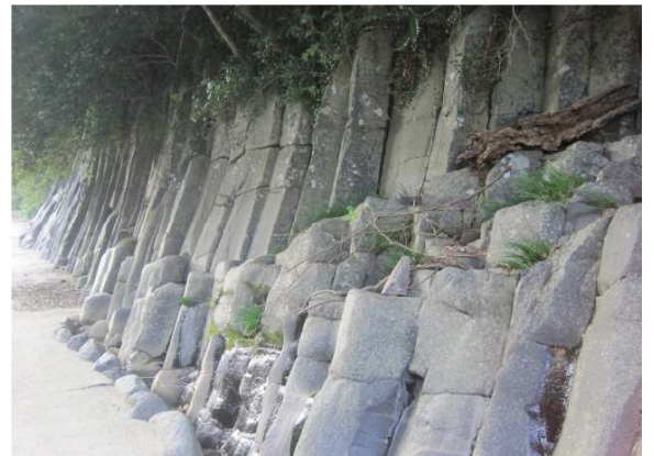
角材状の割れ目が見られる立野ダム予定地の岩盤
