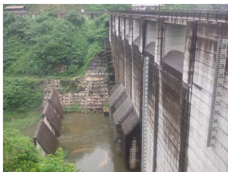
益田川ダム本体の上流側
