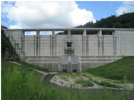
上流側から見た辰巳ダム本体 2015.8.24撮影
