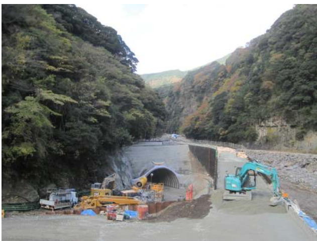
立野ダム仮排水路工事の状況 2014.11.22撮影
