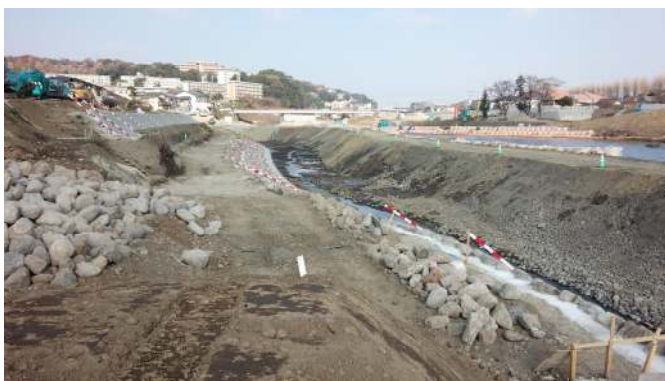
改修工事が進む小碓橋下流右岸 2014.12.30撮影
