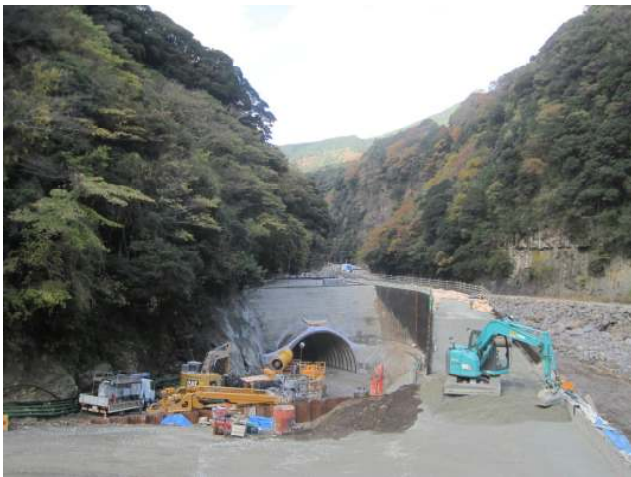
立野ダム仮排水路工事の状況 2014.11.22撮影
