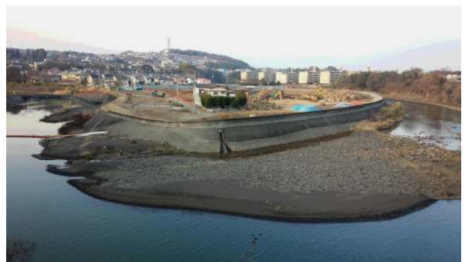
改修工事が進む龍田陳内4丁目 2015.2.6撮影
