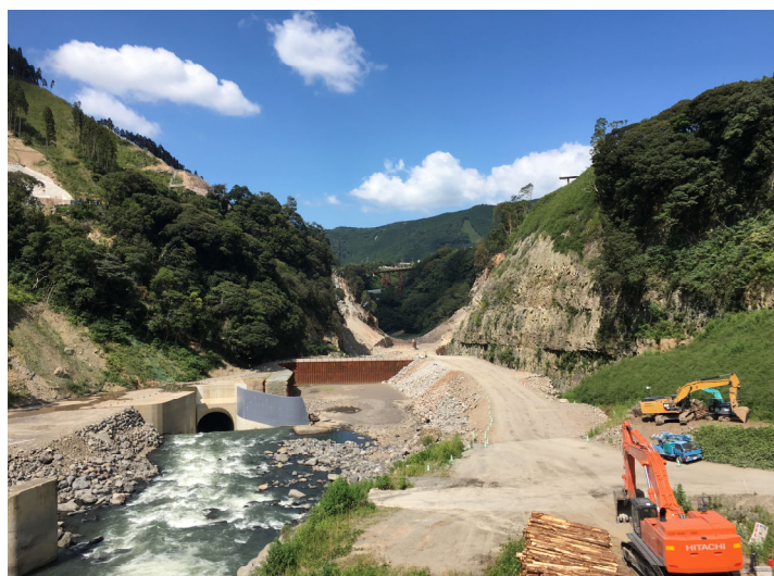
立野ダム建設現場(上流より) 2019.9.15撮影
