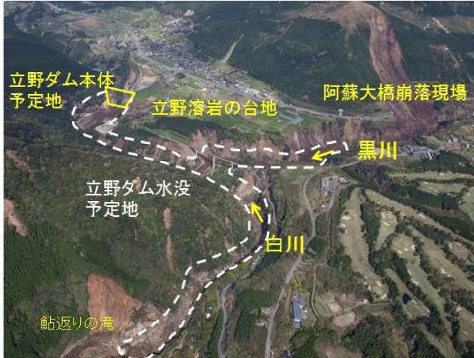
熊本地震で大半が土砂崩壊した 立野ダム水没予定地(パスコ航空写真に加筆)
