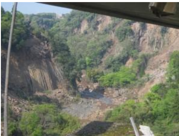
立野溶岩の柱状節理です。写真上は、長陽大橋の橋の下です。今度来るときは、この写真を撮影した場所は崩落していると思われます。決死の撮影でした。(終わり)
