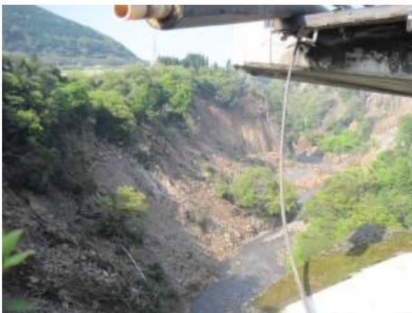
戸下温泉や黒川橋(石橋)のあった谷です。2012年7月の九州北部豪雨以上の大崩落です。流れるのは黒川です。このような、数百年に一度の大地震や大洪水で崩れ、削られ、立野峡谷は形成されたのです。そんな場所に、よくも巨大なダム建設を計画したものです。
