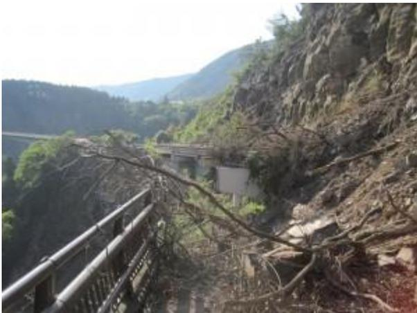
長陽大橋東側(栃木方面)の道路は、合流点付近の白川を上流側に延長したあたりが大崩壊しています。ちょうどこのあたりを、今回の地震で動いた布田川断層帯の一部である北向山断層が通っていると思われます。アソシエートの真下付近です。写真の左側に見えるのが長陽大橋です。
