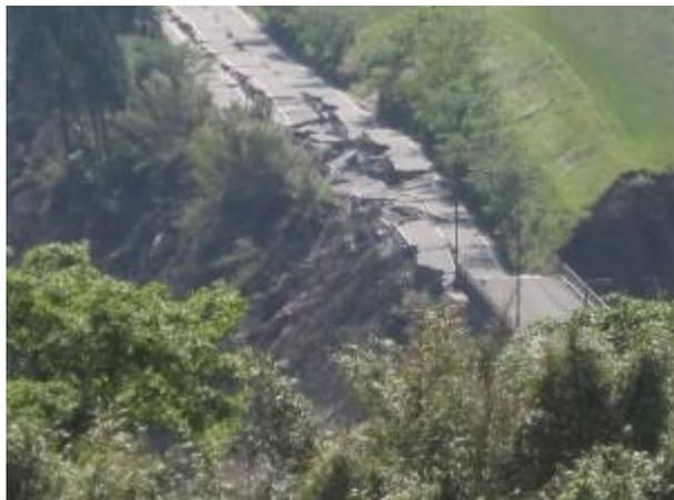
長陽大橋付け根(西側)の道路は、4月19日に調査した時よりさらに斜面崩壊が進み、舗装も崩れて波打ち、とても現地にはたどり着けない状況です。
