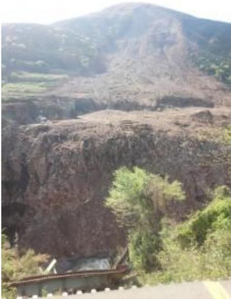
決壊した阿蘇大橋を長陽側から見ました。対岸の崩壊した土砂の左側に阿蘇大橋の基礎部分が小さく見え、斜面崩壊の規模の大きさに驚きました。
