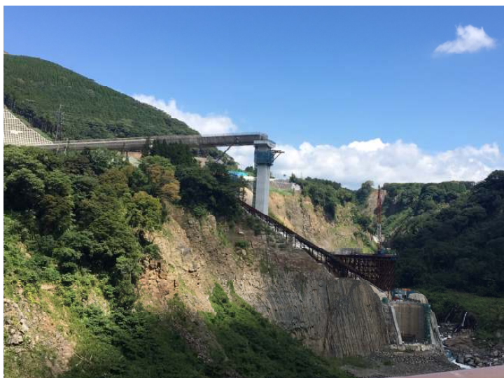
阿蘇大橋建設現場(長陽大橋より)2019.9.15撮影
