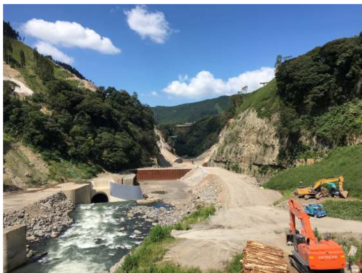
立野ダム建設現場(上流より)2019.9.15撮影
