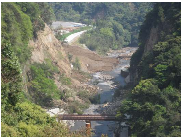
地震で崩落した立野ダム本体予定地2016.4.19
