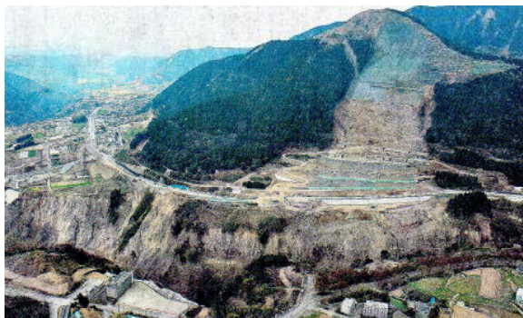
土砂崩壊が進む立野峡谷 2019.4.12熊日新聞
