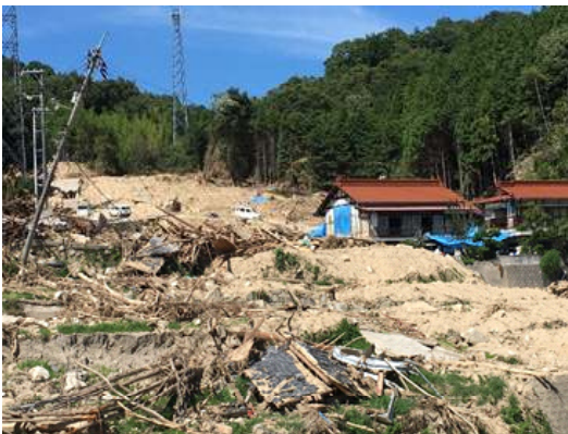
野呂川ダム上流の土砂災害現場 2018.8.8
