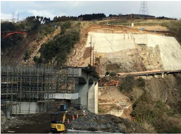
コンクリートで固められた長陽大橋東側 2017.2.13
