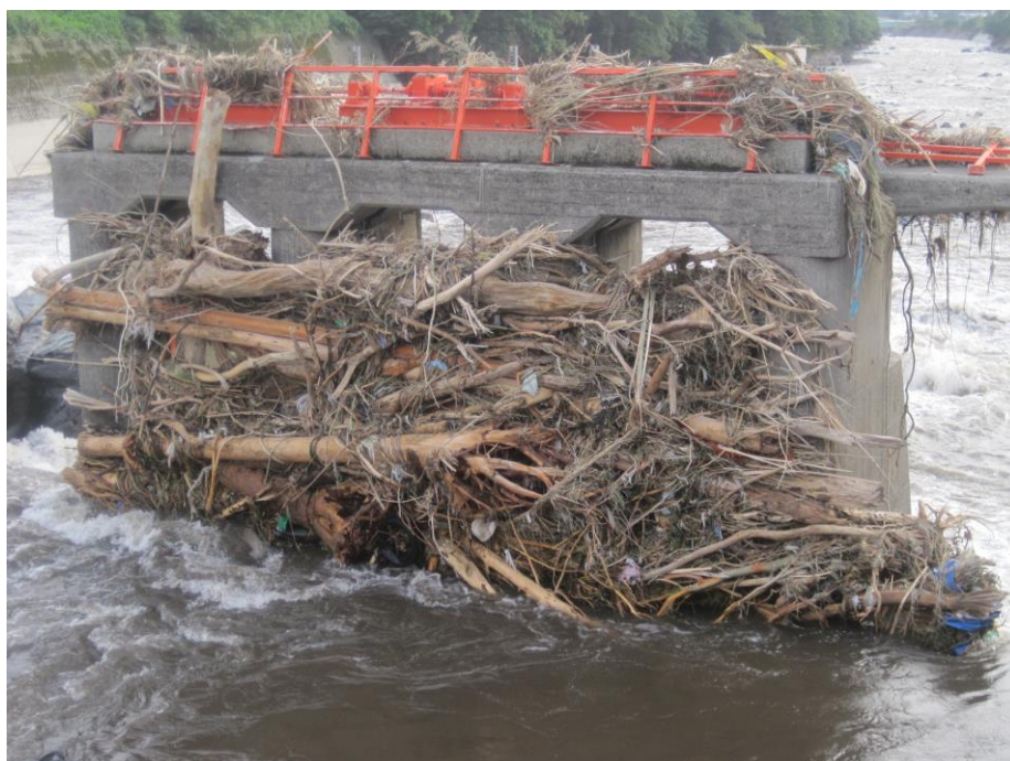
九州北部豪雨時、流木等でふさがった下井手取水堰 2012年7月15日撮影 流木や木の枝葉、根、その他の浮遊物が絡み合い、堰に貼りついている。 当然、立野ダム放流孔のスクリーンの20cmの隙間に食い込み、貼りつくことは明らか。 食い込み、貼りついた流木などがダムの水位が上昇すれば浮くことは考えられない。
