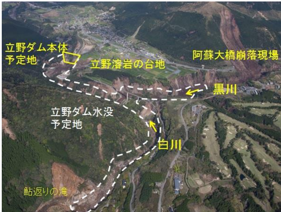
熊本地震後の立野ダム水没予定地。大半が土砂崩壊をしている。(パスコ航空写真に加筆) ダムの水位が上がれば、立野溶岩の表面に堆積した火山性堆積物が崩れ、 湛水(たんすい)地すべりが発生するのは明らかです。
