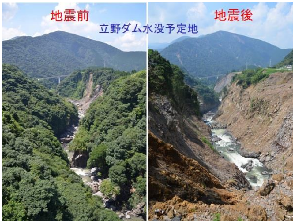
地震前後の立野ダム水没予定地。黒川上流側から白川黒川合流点を望む。 奥に見えるのが長陽大橋。 これでは道路をつくることができないので、重機やダンプを下すことができません。 土砂の搬出も不可能だし、土砂崩壊対策工事也不可能です。
