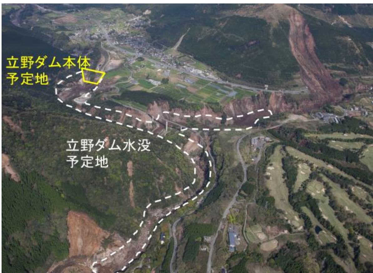
両岸の大半が崩壊した立野ダム水没予定地周辺(パスコホームページの写真に加筆)
