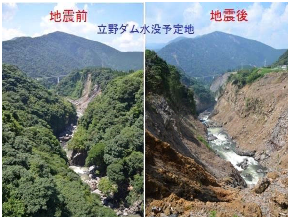
熊本地震前後の立野ダム水没予定地。黒川上流側から北向山方面を望む。奥に見えるのが長陽大橋。 これでは下りていく道路をつくることのできないので、重機やダンプを下すことができない。 土砂の搬出や、土砂崩壊対策工事も不可能である。
