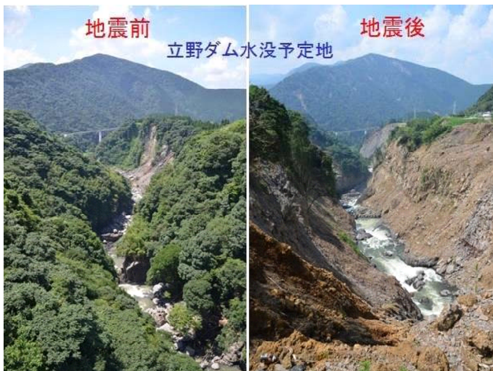
熊本地震前後の立野ダム水没予定地。黒川上流側から北向山方面を望む。奥に見えるのが長陽大橋。 これでは下りていく道路をつくることができないので、重機やダンプを下すことができない。 土砂の搬出や、土砂崩壊対策工事も不可能である。
