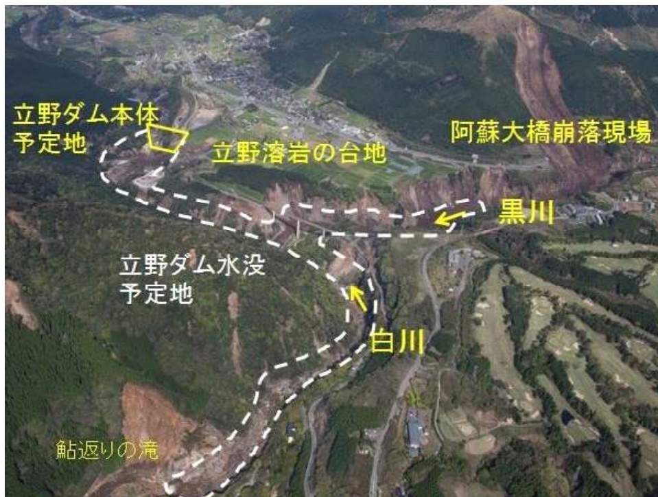
熊本地震後の立野ダム水没予定地。大半が土砂崩壊をしている。(パスコ航空写真に加筆) ダムの水位が上がれば、立野溶岩の表面に堆積した火山性堆積物が崩れ、 湛水(たんすい)地すべりが発生するのは明らかである。
