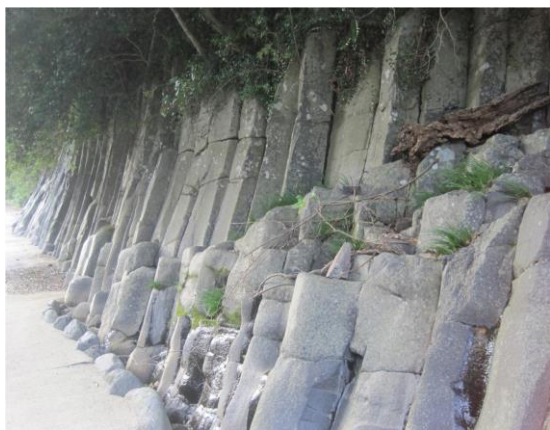
角材状の割れ目（柱状節理）が多く見られる 立野ダム予定地の岩盤（右岸側） 2011年10月10日撮影
